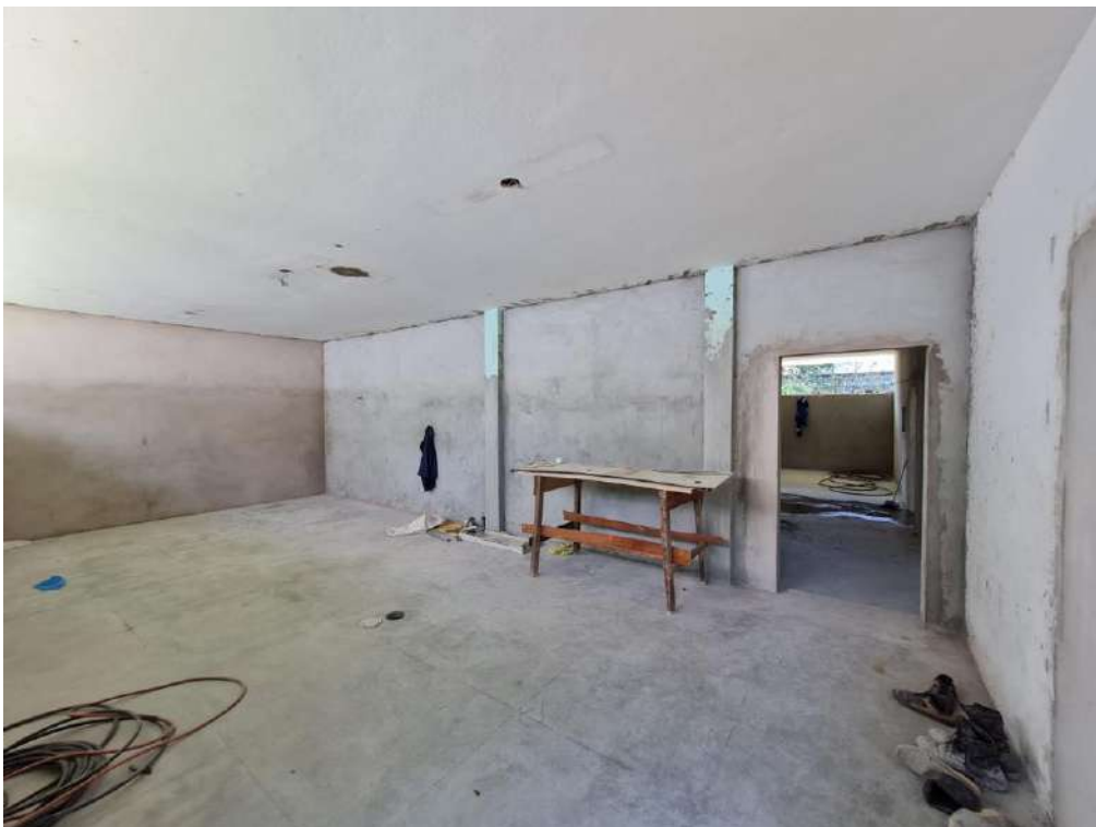
Figura 20: Sala de aula - retirada de azulejos, retirada de esquadria, fechamento em alvenaria, revestimento em chapisco e reboco, arremate em vãos de janelas e portas.
