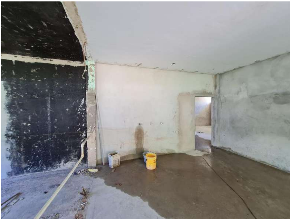
Figura 10: Laboratório de bromatologia – demolição de parede, chapisco e reboco parcialmente executado
