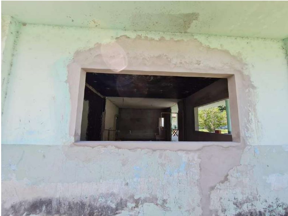
Figura 05: Lateral A da edificação – compressor retirado, verga e contraverga executada; arremate em chapisco e reboco (Lab. de bromatologia)
