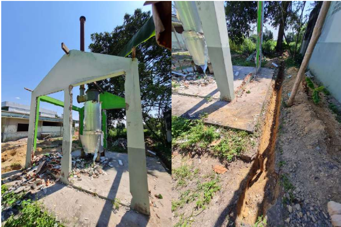
Figuras 27 e 28: Área de defumação – cobogós demolidos, portão retirado; escavação para desvio de tubulação de esgoto
