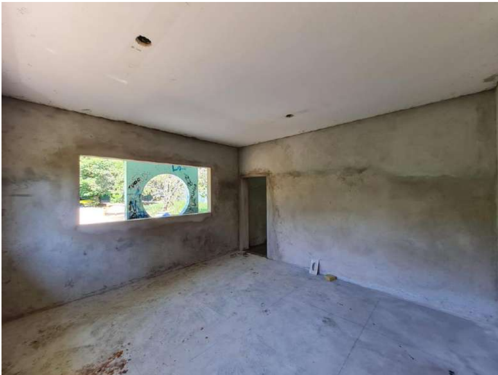
Figura 14: Sala das técnicas de alimentos - revestimento em chapisco e reboco executado, verga e contraverga executadas, vão de janela executado
