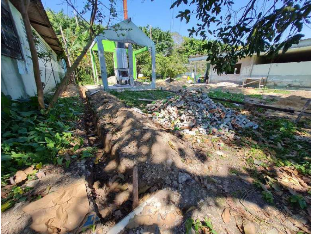
Figura 26: Infraestrutura do vestiário – escavação para desvio da tubulação
