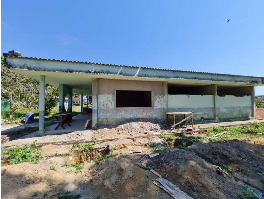
Figura 04: Vista lateral B da edificação – esquadrias retiradas (geral), verga e contravergas executada e fechamento de vão em alvenaria na sala das técnicas de alimentos.
