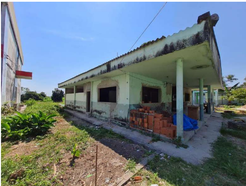
Figura 03: Vista panorâmica da edificação – esquadrias retiradas, vergas e scontravergas executadas.
