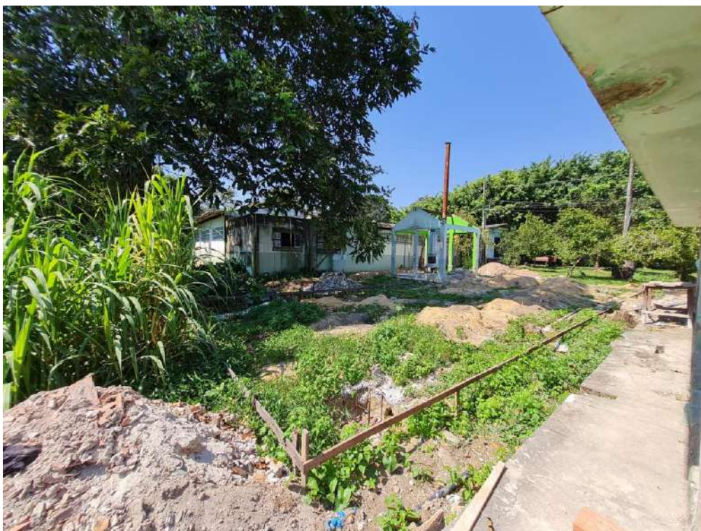
Figura 22: Infraestrutura do vestiário – locação executada; volume de material escavado à esquerda.
