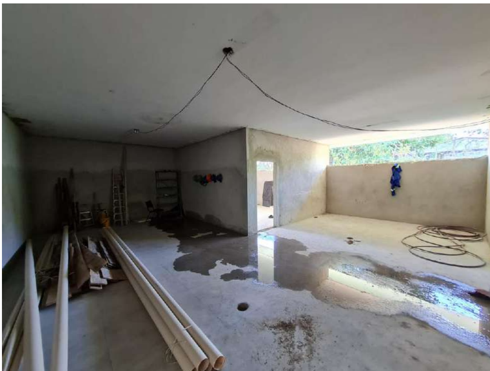
Figura 15: Laboratório de tecnologia de alimentos – retirada de azulejos, retirada de esquadria, fechamento em alvenaria, revestimento em chapisco e reboco, arremate em vãos de janelas e portas
