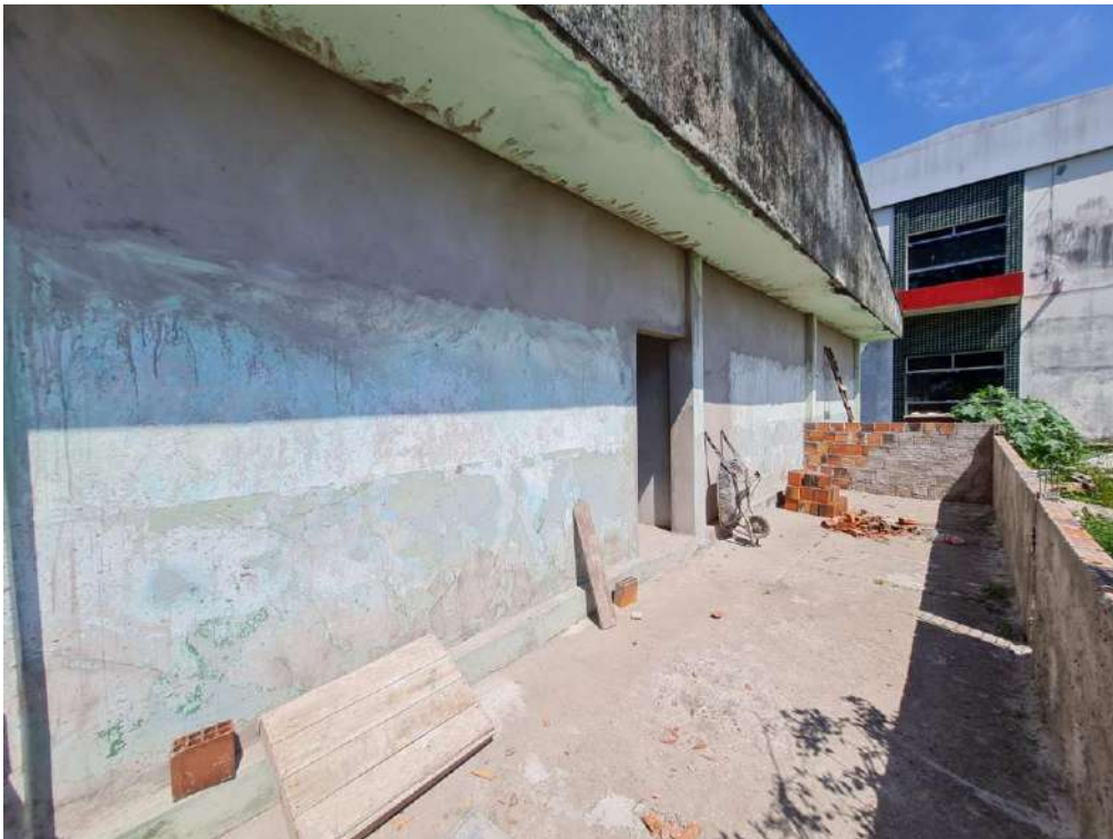
Figura 07: Área externa da edificação – esquadrias retiradas, fechamento em alvenaria, chapisco e reboco (área de secagem de peixes)
