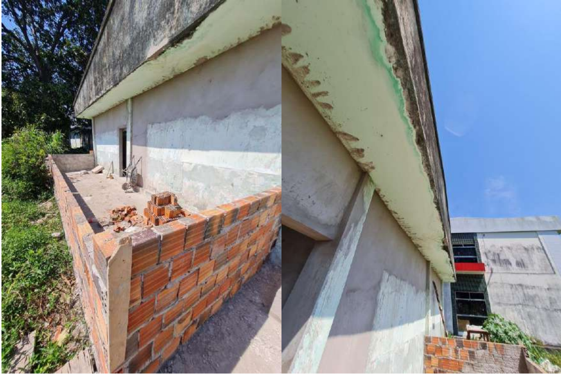
Figuras 08 e 09: Área externa da edificação – alvenaria parcialmente executada
