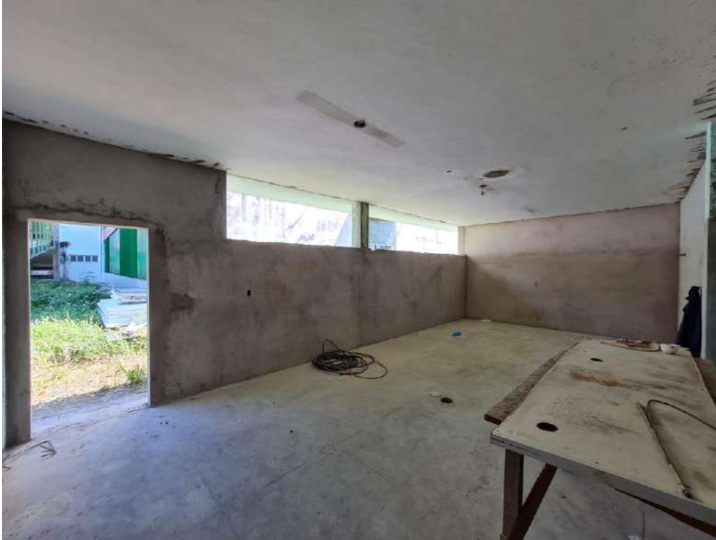
Figura 19: Sala de aula - retirada de azulejos, retirada de esquadria, fechamento em alvenaria, revestimento em chapisco e reboco, arremate em vãos de janelas e portas.
