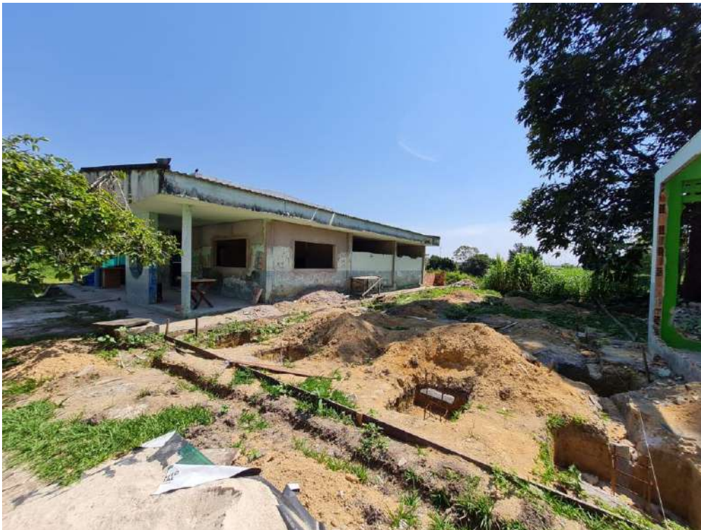
Figura 21: Infraestrutura do vestiário – locação executada, escavação para 17 sapatas e vigas baldrame, 13 sapatas concretadas com arranque de pilares;
