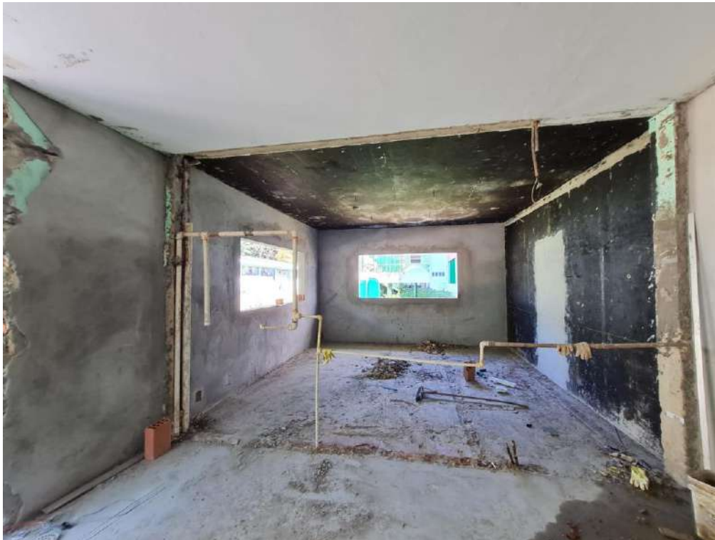
Figura 11: Laboratório de bromatologia – demolição parcial da câmara frigorífica executada
