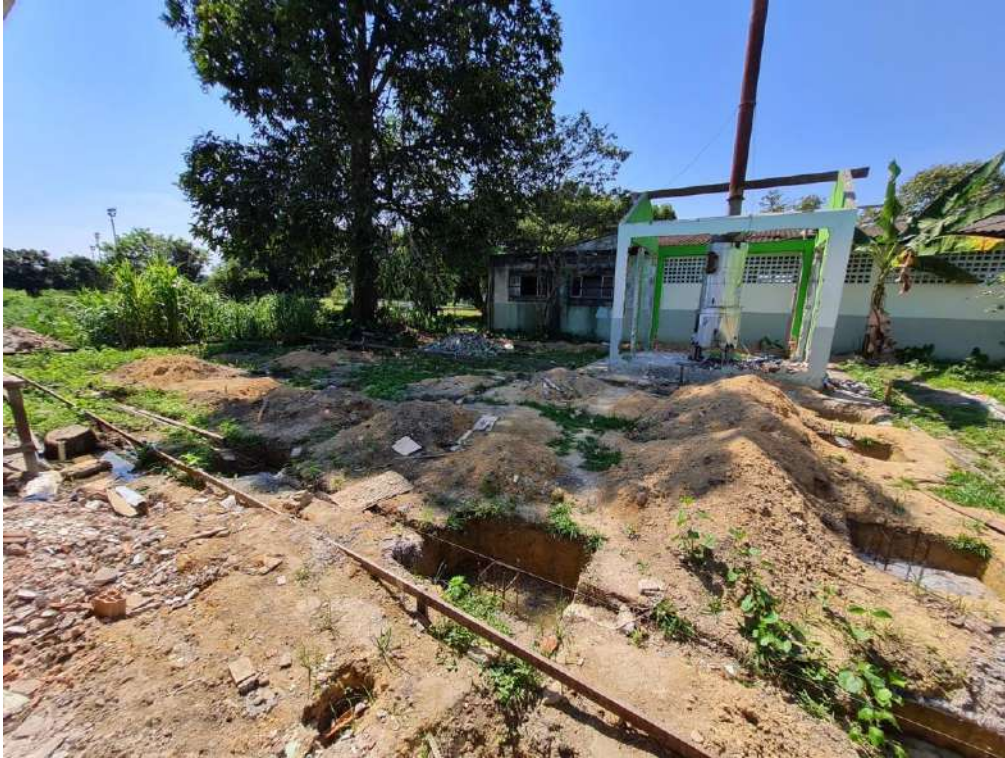
Figura 23: Infraestrutura do vestiário – 14 sapatas e arranques executados;
