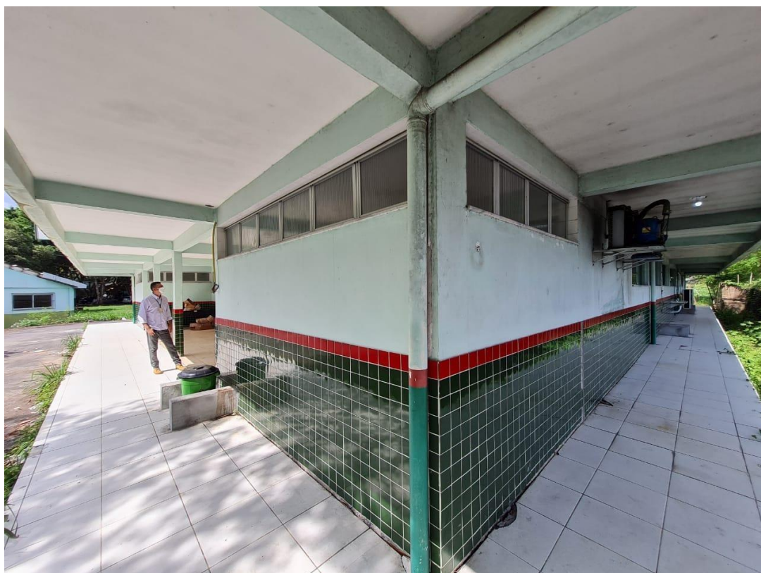
Imagem 08 – Fundo do refeitório e lado B Fonte: OLIVEIRA, A.F.
