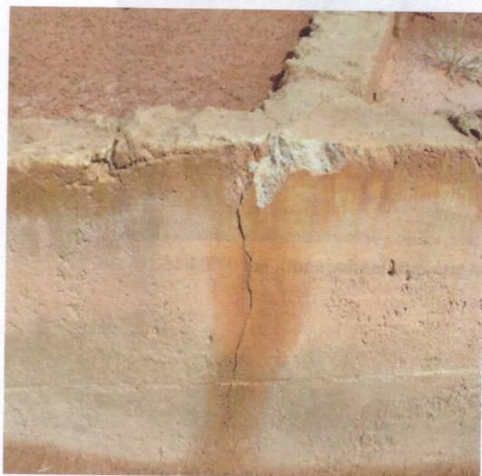
Figura 1 - Vigas Baldrames Trincadas, em 07/04/15.
