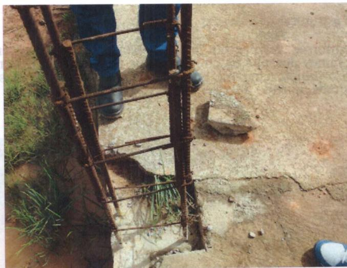
Figura 5 - Estribos com espaçamento inadequado, em 07/04/15.
